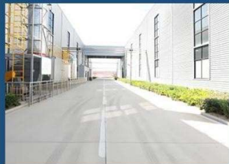
Allée de l'usine
