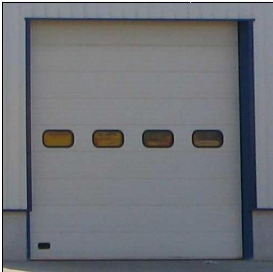
*Idéales dans les situations où il est nécessaire d'éviter les courants d'air mais où des entrées et sorties de véhicules sont fréquentes et exigent une ouverture et fermeture rapide des portes.*
