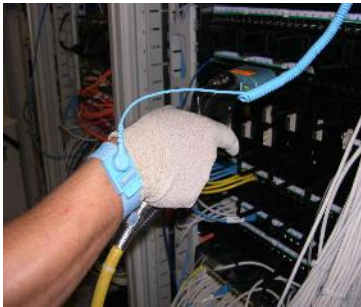
Soufflage d'air basse pression avec un pistolet ionisant. Technicien équipé d'un bracelet antistatique et gants
