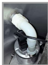
A l'intérieur de la cuve
