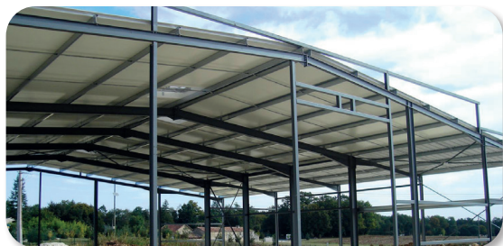
■ Marquage profond sur charpentes métalliques
