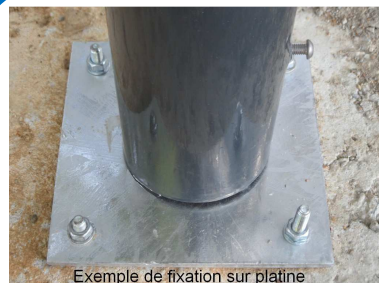
Exemple de fixation sur platine
