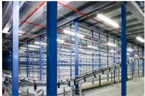
La plateforme de stockage répond aux normes EN1090-1 et 1090-2 et sont certifiées CE. La réalisation est faite sur mesure en fonction de votre bâtiment et vos besoins. Le montage est simple et rapide.
