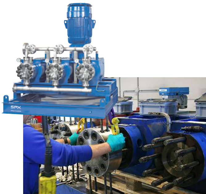
MAINTENANCE SUR DES POMPES BRAN+LUEBBE
